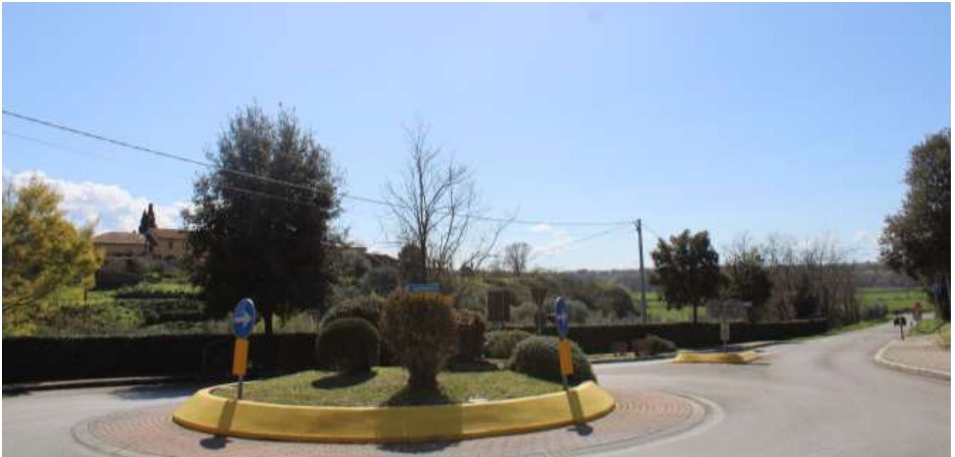
Figura 4—15 Foto dal PdO 32 in direzione dell’impianto.
