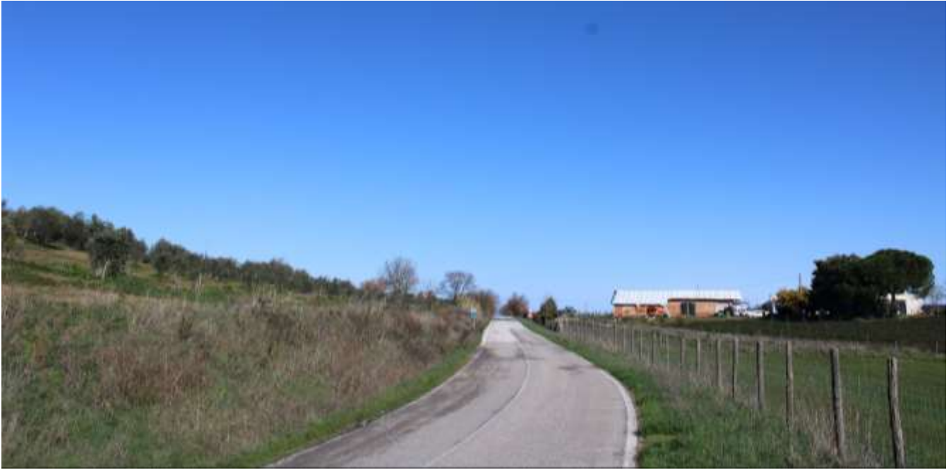
Figura 4—21 Foto della Strada provinciale 79, in corrispondenza del PdO28.
