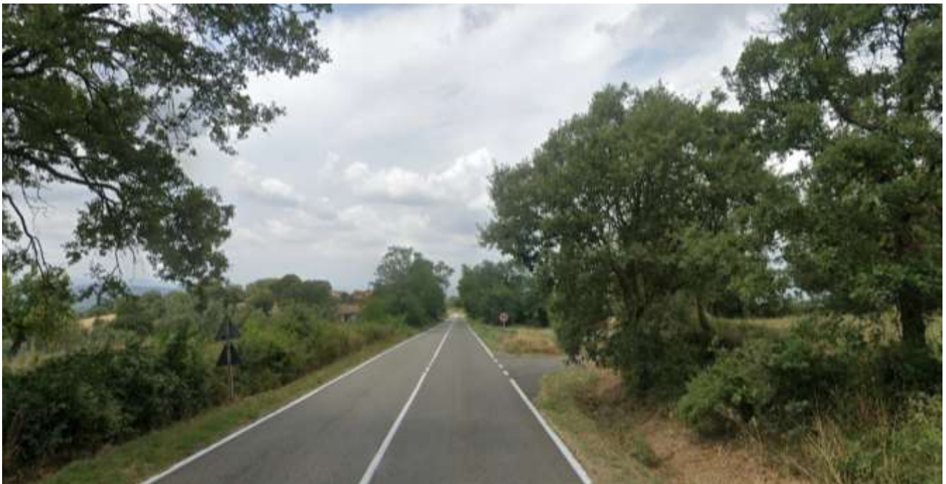
Figura 4—14 Foto dal PdO 2 in direzione dell'impianto.
